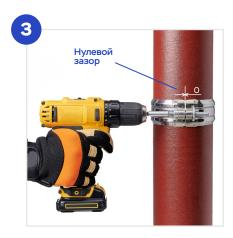
Затяните винт до упора (нулевой зазор) с помощью шестигранного ключа или электрического гайковерта.
