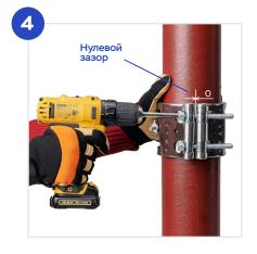
Установка будет завершена, когда винты затянут до упора (нулевой зазор) и внешние края половинок хомута соприкасаются друг с другом.
