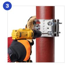
Попеременно затяните винты гайковертом так, чтобы блокирующие части затягивались параллельно и на одинаковом расстоянии, следите что бы положение хомута соответствовало ранее нанесенным меткам.
