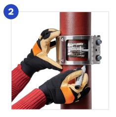
Выравнивайте положение усиливающего хомута на одинаковом расстоянии от верхнего и нижнего края хомута Rapid «САПСАН», для удобства нанесите отметки на соединенных трубах (фитингов).
