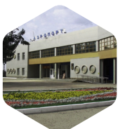
Чебоксарский аэропорт г. Чебоксары 2020
