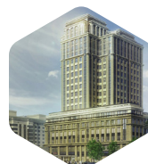
Бизнес-центр «FORT TOWER» г. Санкт-Петербург 2016
