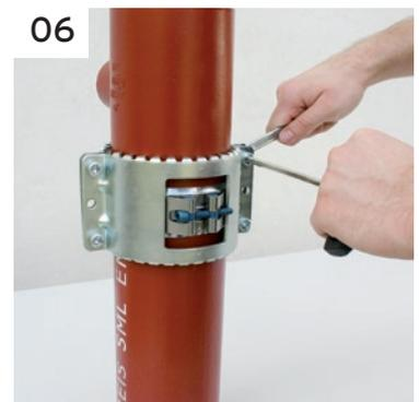
**PREIS® Rapid Verbinder** und **PREIS® Rapid Krallen** haben beide eine Innensechskantschraube mit 6mm. Dies ermöglicht es, beide Elemente mit nur einem Werkzeug zu befestigen. Für den Anzug können handelsübliche Akkuschauber, Steckschlüssel oder Handratschen verwendet werden. In jedem Fall sind die angegebenen Anzugsmomente zu beachten.
